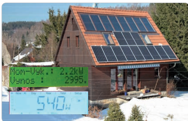
Obr. 1 Fotovoltaický i fototermální systém v rámci jednoho RD s aktuálním výkonem obou technologií
